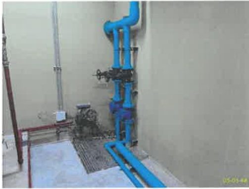
เครื่องสูบน้ำ การระบายน้ำชั้นใต้ดินอาคาร A
