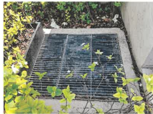
บ่อสุดท้ายก่อนปล่อยลงสาธารณะ ระบบระบายภายนอกอาคาร ภาพที่ 2.2-12 (ต่อ) การระบายน้ำโครงการ
