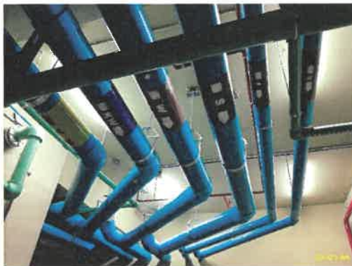
ท่อน้ำเสีย ท่อระบายน้ำภายในอาคาร ภาพที่ 2.2-12 การระบายน้ำของโครงการ
