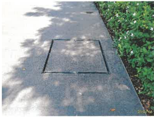
ระบายน้ำฝนรอบโครงการ ท่อระบายน้ำภายนอกอาคาร
