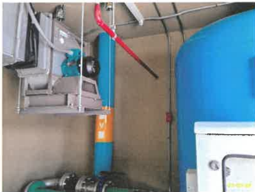
ชั้นดาดฟ้า ปั๊ม และถังเก็บน้ำสำรองเพื่อการอุปโภค-บริโภค อาคาร B ภาพที่ 2.2-8 (ต่อ) ระบบน้ำใช้โครงการ
