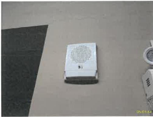
กริ่งสัญญาณเตือนอัคคีภัย ระบบเตือนอัคคีภัย (ต่อ)
