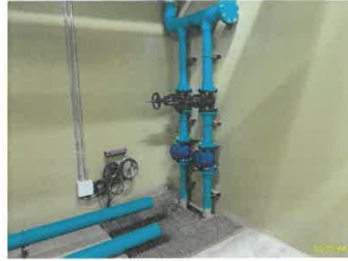
เครื่องสูบน้ำ การระบายน้ำชั้นใต้ดินอาคาร A
