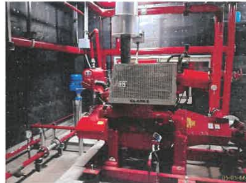
เครื่องสูบน้ำดับเพลิงชั้น 28M
