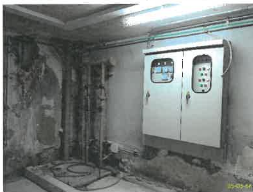
เครื่องสูบน้ำ และตู้ควบคุม การระบายน้ำชั้นใต้ดินอาคาร B ท่อระบายน้ำภายในอาคาร (ต่อ) ภาพที่ 2.2-12 (ต่อ) การระบายน้ำโครงการ
